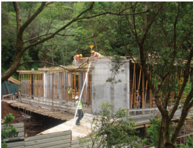
IMAGEM 16 Construção do CVFE (2008-2010). Foto: Pedro Raposo.
