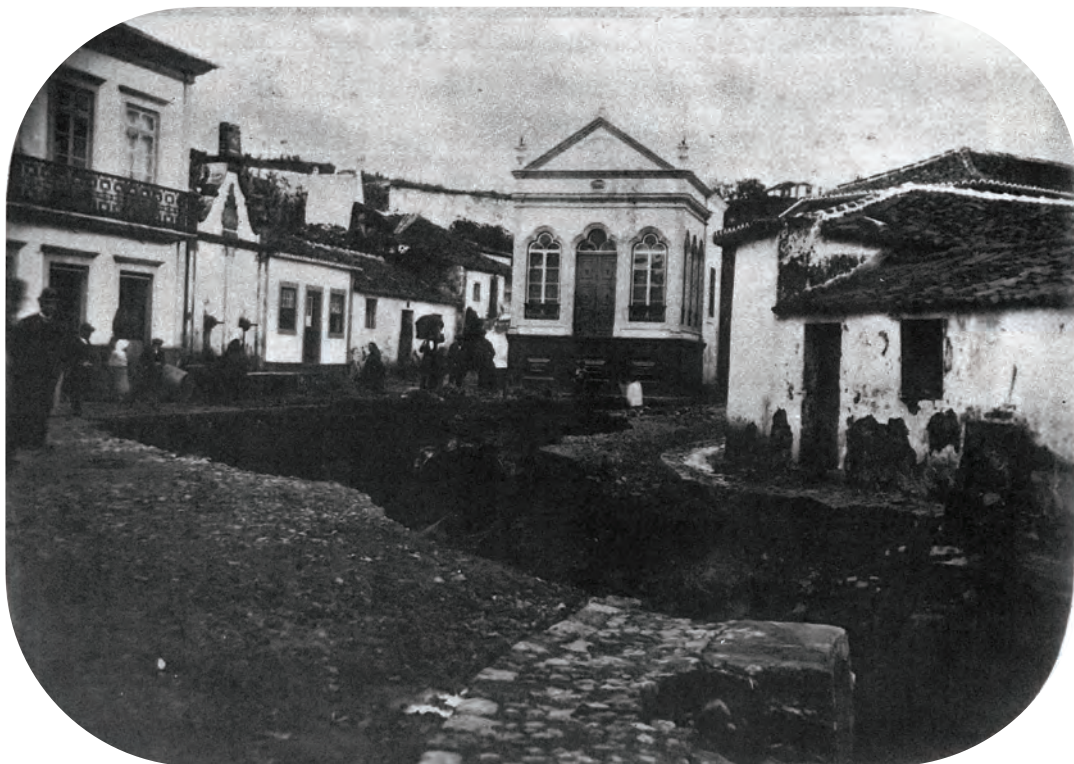
A profunda vala aberta pela Ribeira de São Bento quando transbordou junto ao largo em julho de 1891.
