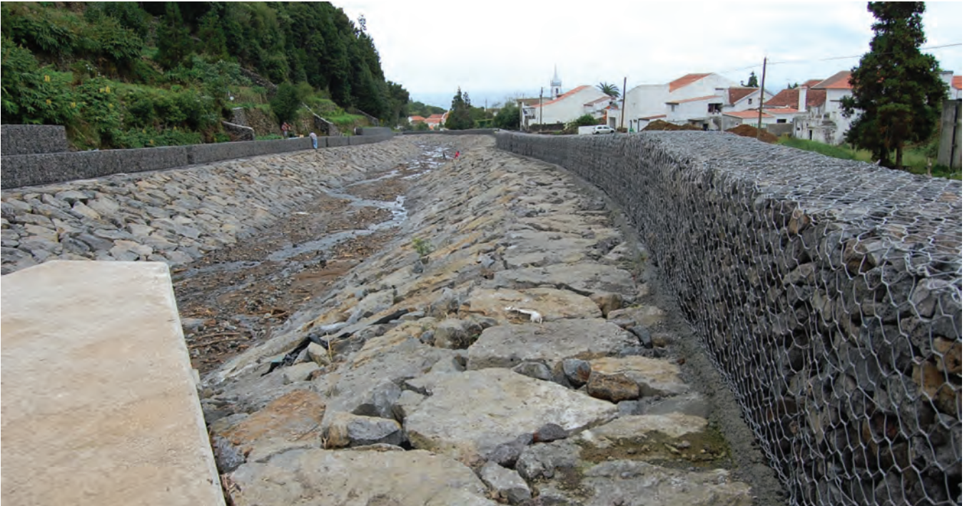
Troço da Ribeira da Agualva artificializado após as obras executadas em consequência das enxurradas de 15 de dezembro de 2009. Foto de outubro 2011. FP
