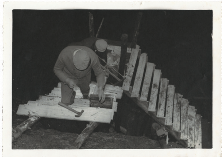
1968. Construção de escadaria em madeira no interior do Algar do Carvão.
