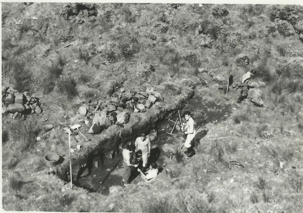
1965. Início da abertura do túnel de acesso ao Algar do Carvão.
